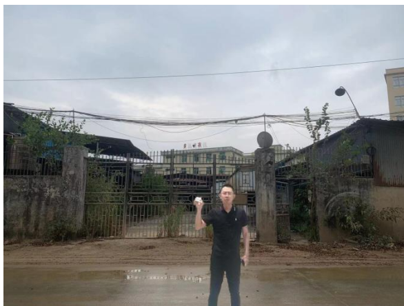
工程师现场踏勘图
