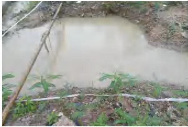
场内水做排水沟和集水池，沉淀过滤后循环使用，用于现场工地临时用水
