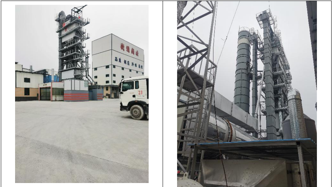
沥青混凝土生产线
