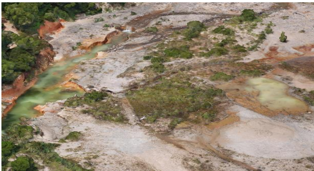
图 3-9 排土场正面照片
