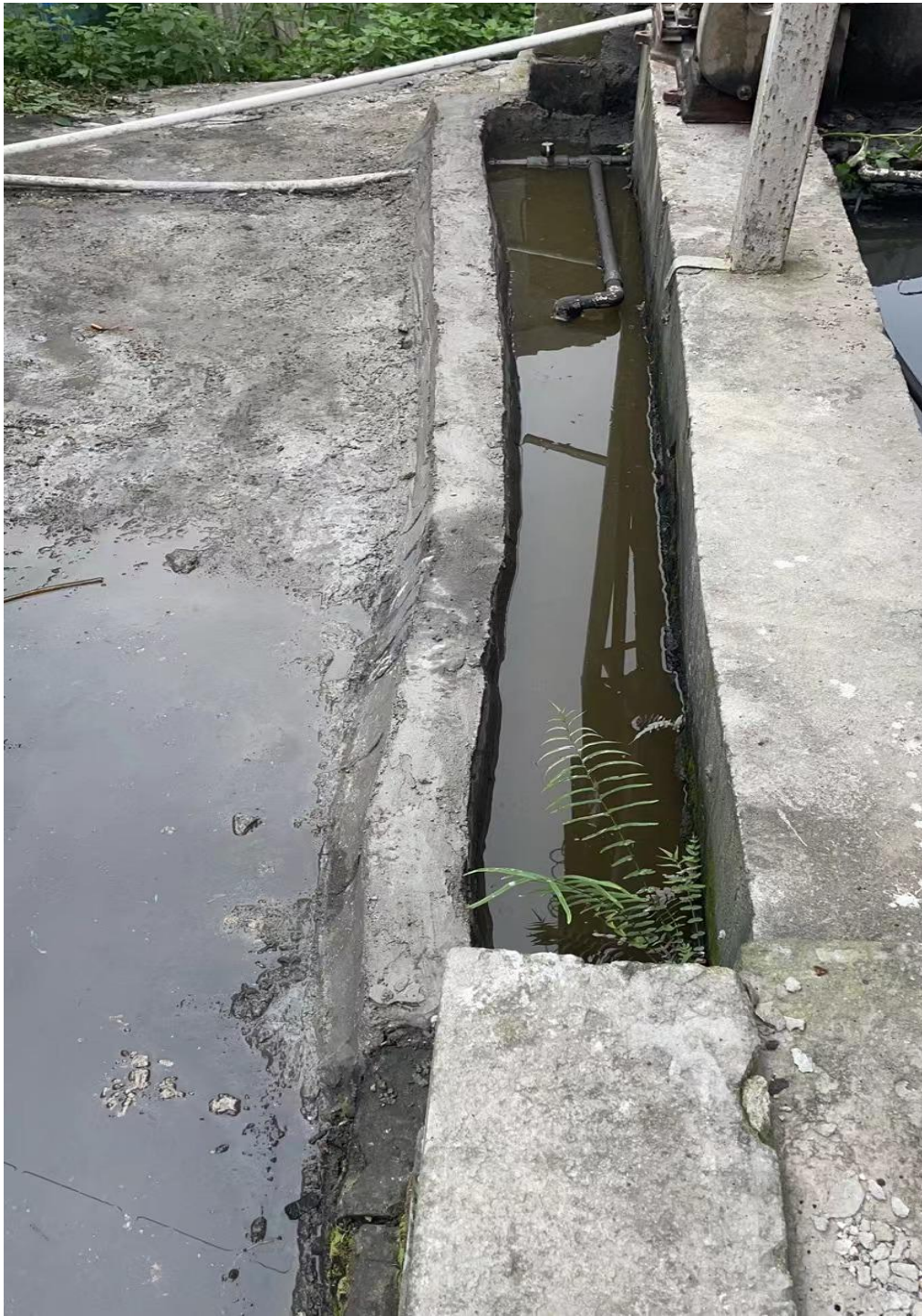
锅炉除尘废水池
