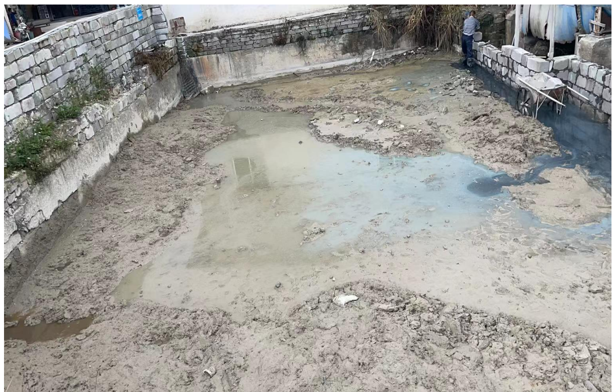
回用水池兼事故应急池
