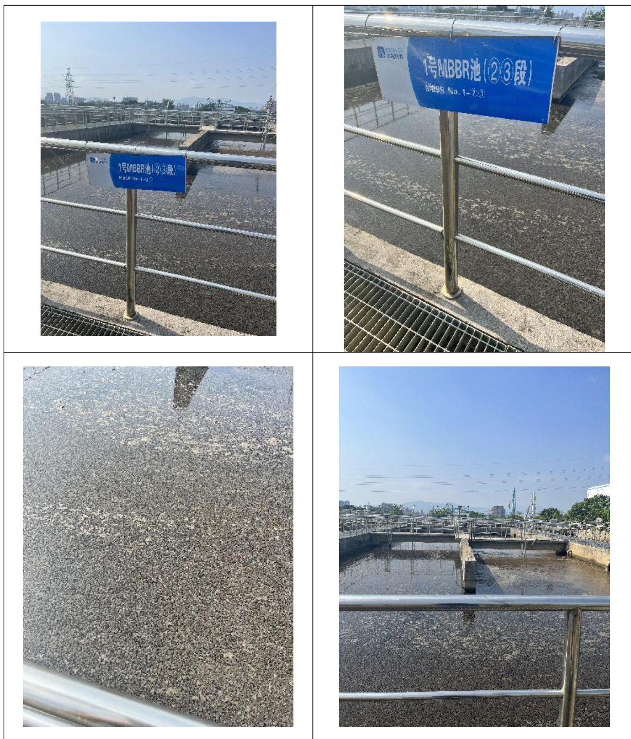
项目主要建设内容现状见图 3-5
