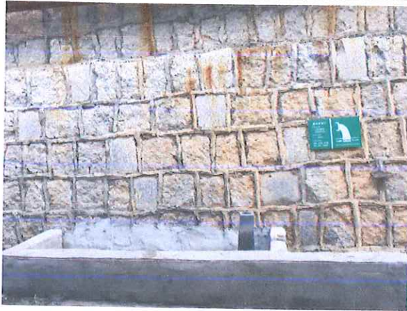
生产废水排放口
